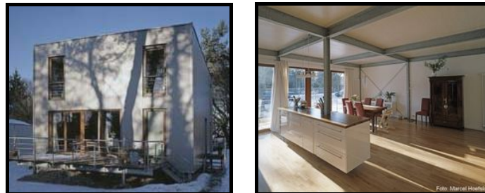
Bild 2: Einfamilienhaus in Stahlbauweise gemäß http://www.rsb-stahlbau.de/
