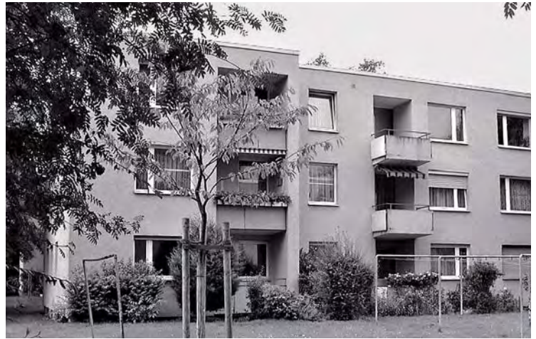
Die Bestandsgebäude vor der Sanierung
