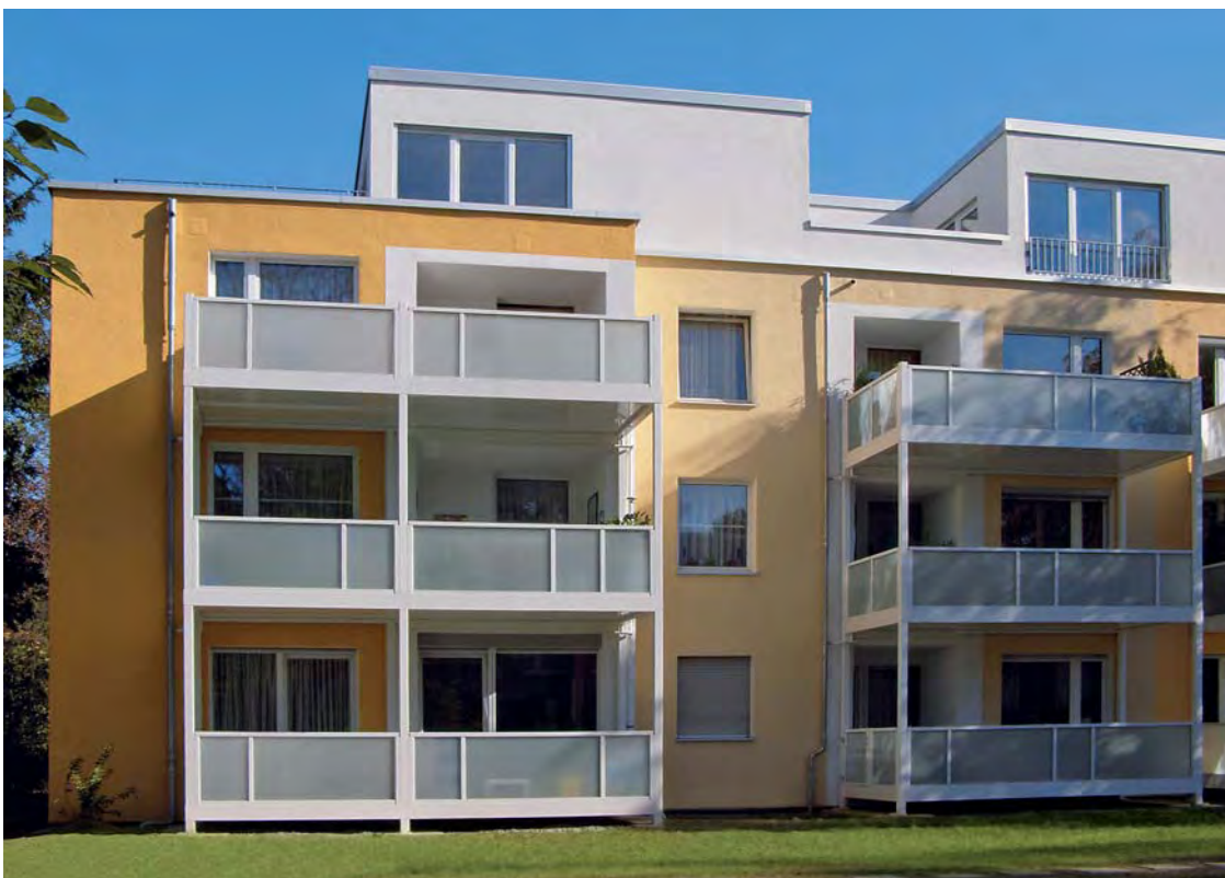
Gartenansicht nach der Sanierung mit eingeschossiger Aufstockung
