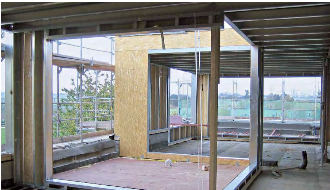
Montage der Wand- und Dachelemente als Halbfertigteile vor Schließen der Konstruktion mit innenliegender Beplankung im Zuge des Ausbaus
