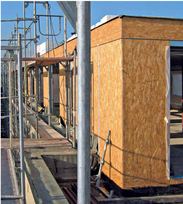
Fertig montierte Stahl-Leichtbauelemente vor Aufbringen des Wärmedämmverbundsystems
