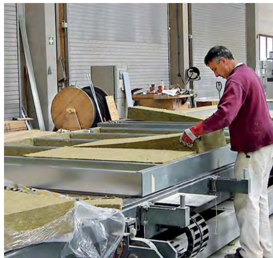
Links: Fügung von Rähm und Ständern auf dem Fertigungstisch Rechts: Fixierung der Ständer und Ausdämmen der Wandelemente mit Mineralwolle
