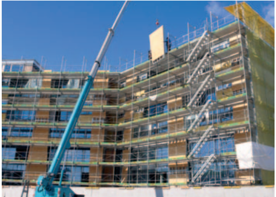
Abb. 5: Montage der vorgefertigten Fassadenelemente
