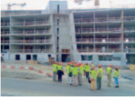
Abb. 4: Gebäude im Skelletbau vor der Montage der Elemente
