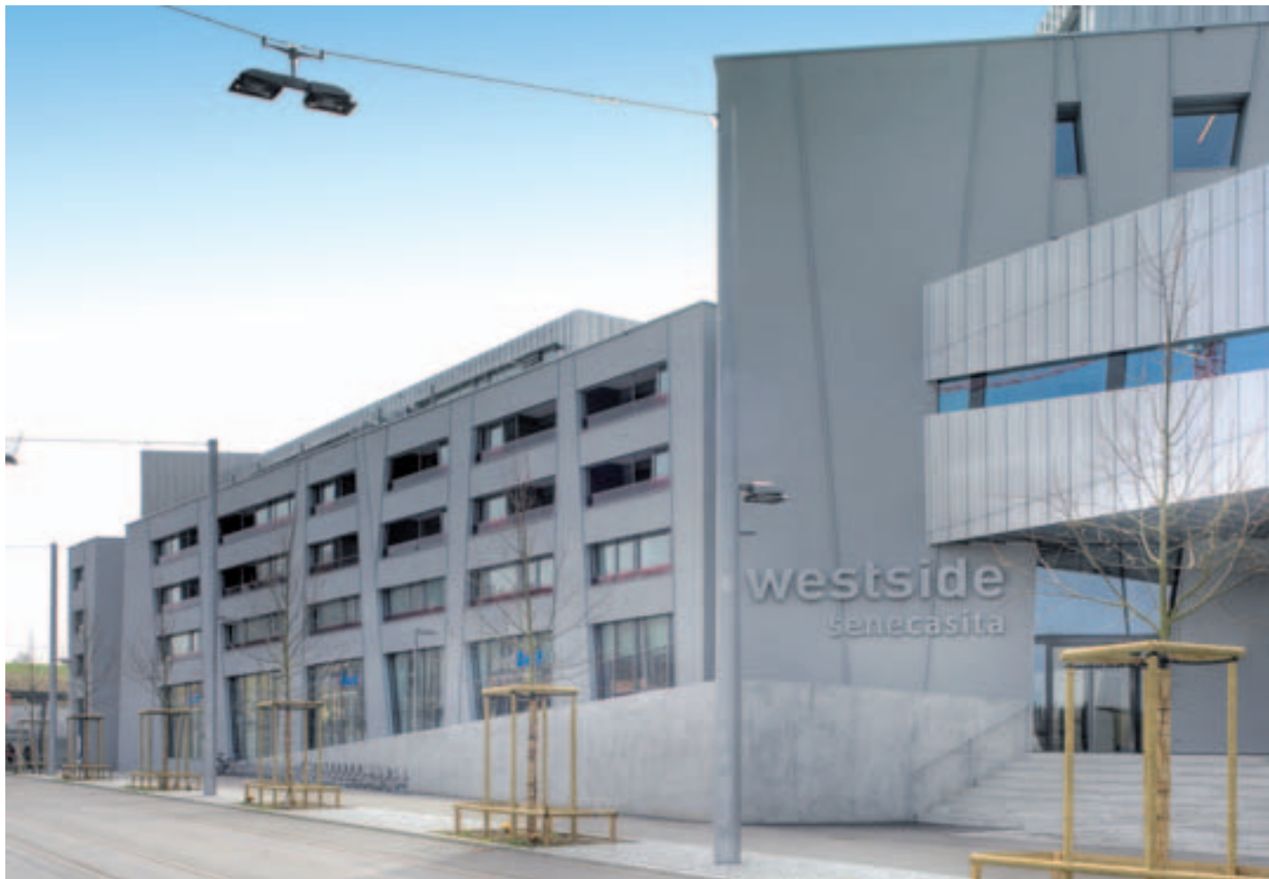
Fertige Fassade Altersresidenz Westside (Vorderseite)
