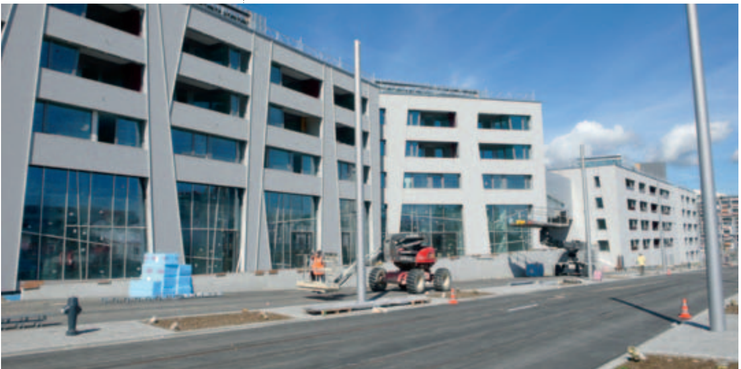
Abb. 6: Fertige Fassade Altersresidenz Westside (Rückseite)
