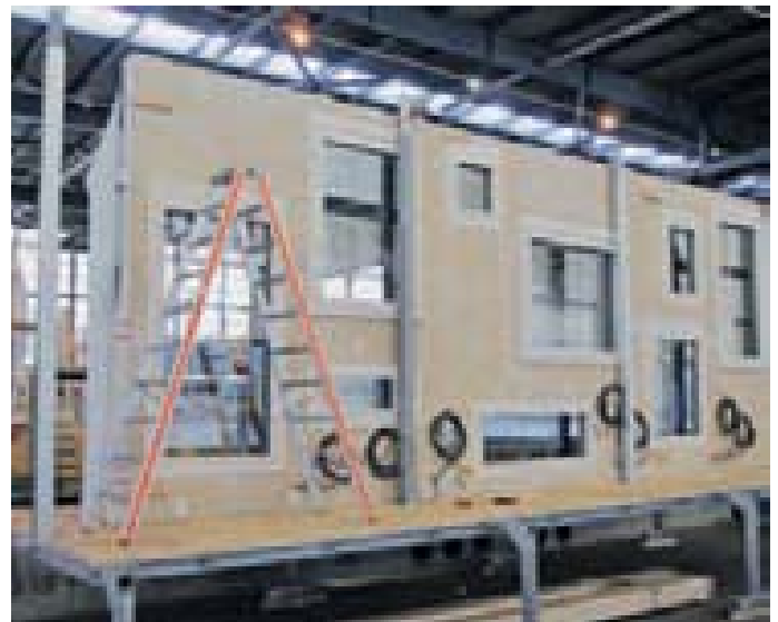
Ein durch die Erne AG Holzbau vorgefertigtes Fassadensystem – es stammt vom Projekt Südpark –, das ebenfalls über leichte Stahlständer verfügt. Foto: zvg
